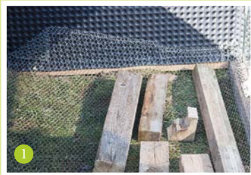
1. Schicht Holzstücke 15–20 cm Ø
